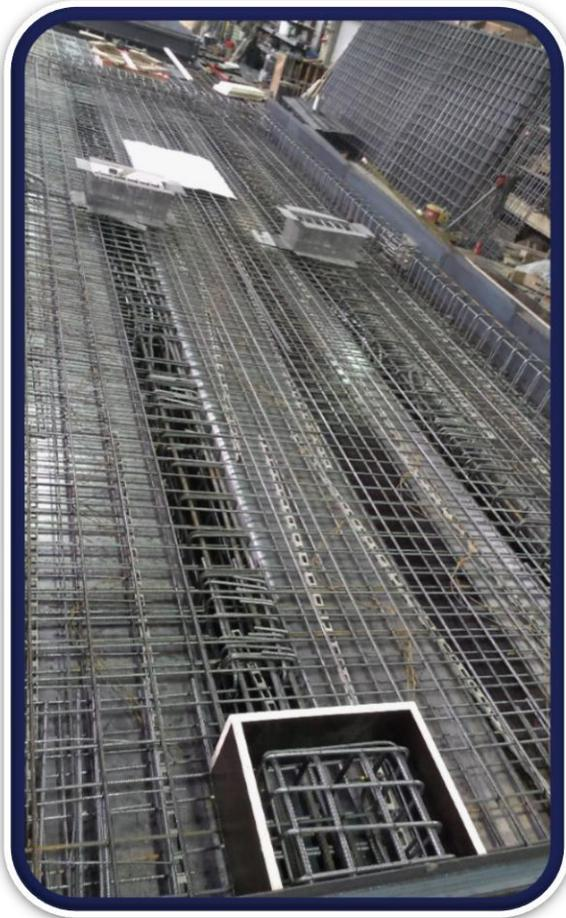
**Direkte Betonage der Dämmung auf die Tragelemente**
